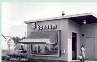
Den första Konsumbutiken etableras och vi bidrar i byggprocessen.
