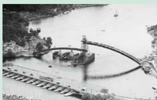
Vi är engagerade i bygget av Tranebergsbron, som påbörjas detta år.
