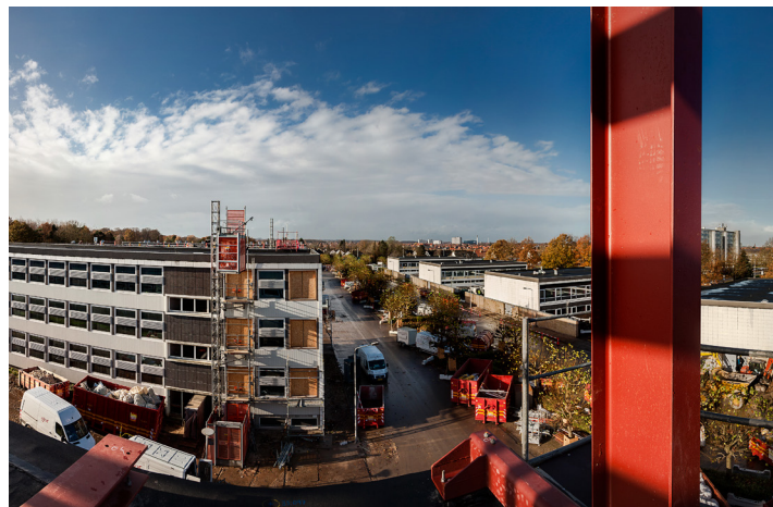
I Odense skapar University College Lillebælt ett nytt campus av sina gamla byggnader. Byggnaderna rivs invändigt för att sedan byggas om helt för att ge plats för nya Campus Odense. Bravida står för vs-, ventilations- och CTS-installationerna.
