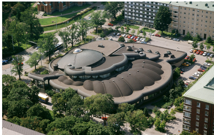
Stadsbiblioteket Metso i Tammerfors stod färdigt 1986. Byggnaden är ett uppskattat kulturobjekt känt för sin arkitektur. Nyligen renoverades biblioteket och Bravida anlitas för att utföra alla elinstallationer.
